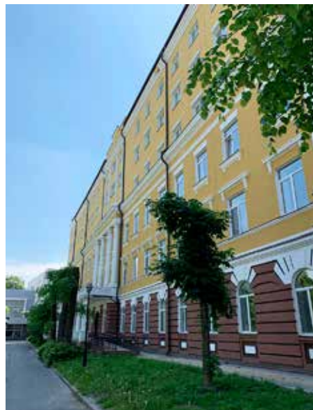
Інститут нейрохірургії, 3-й корпус, після реконструкції. Червень 2020 р.
